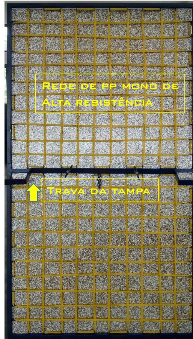
GRADE DE PROTEÇÃO PARA POÇO DE ELEVADOR – ESTRUTURA METÁLICA COM REDE PP MONO VEDADA COM CHAPA TETRA PACK
